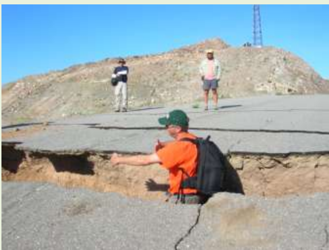
Figura 15. Grieta producida por el sismo. Se aprecia en su interior al Dr Kenneth Hudnut (USGS), mostrando la profundidad de la grieta y cómo se separaron los dos bloques por movimiento de la falla. Fotografía núm. 5765 de la autora, tomada el 27 de abril de 2010 al este de Laguna Salada y al norte de la carretera Tijuana-Mexicali. En el plano posterior figuran Sinan Acsiz (Universidad de California, Irvine) y Steven Skinner (Caltech).
